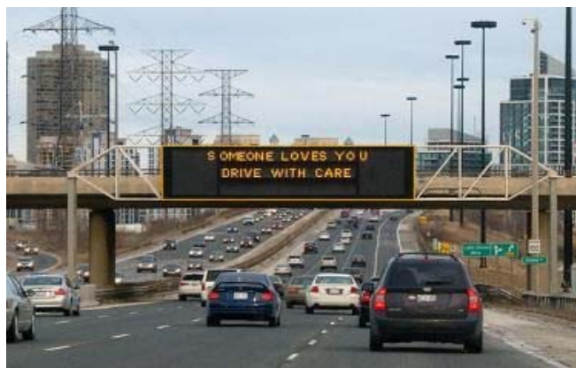
Slika 7. Informacioni displej koji daje poruke vozačima
