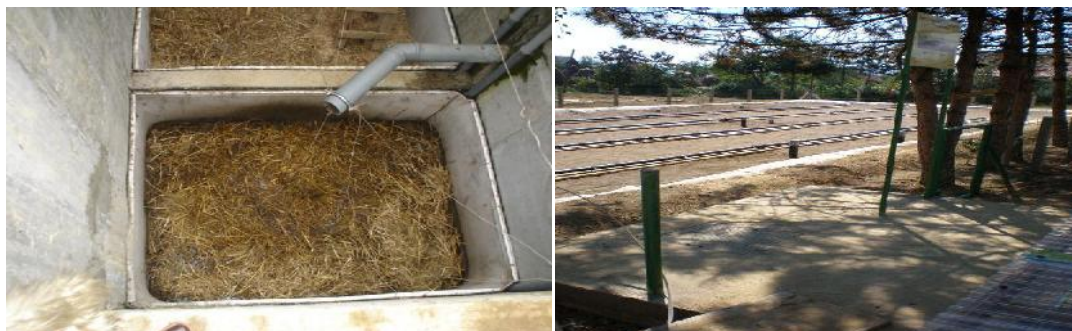
Slika 2. Kompostirajući separator a) i pumpni šaht b) [2]
