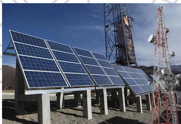
Slika 1. Telekomunikacioni odašiljač napajan sa Solarnim PV modulima
