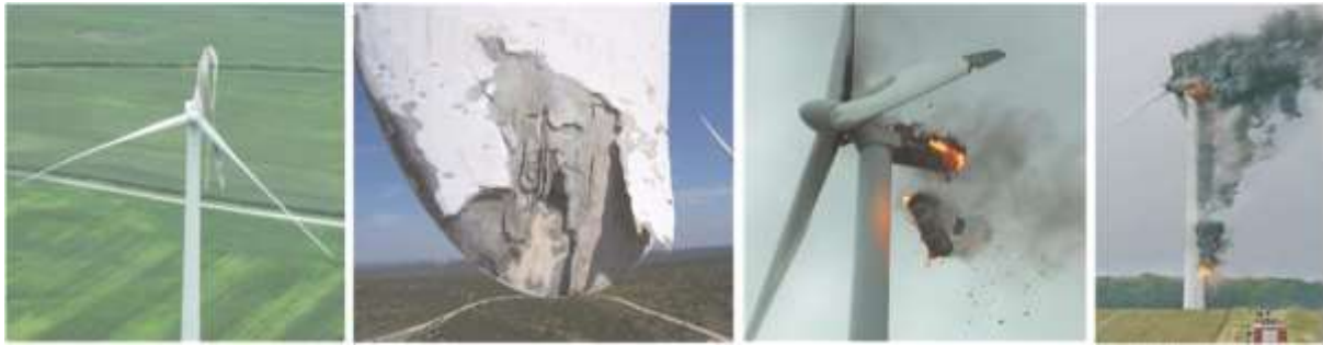
Slika 1. Teška oštećenja koja mogu da nastanu usled direktnog udara groma na lopaticama, gondoli i drugim komponentama vjetroturbine
