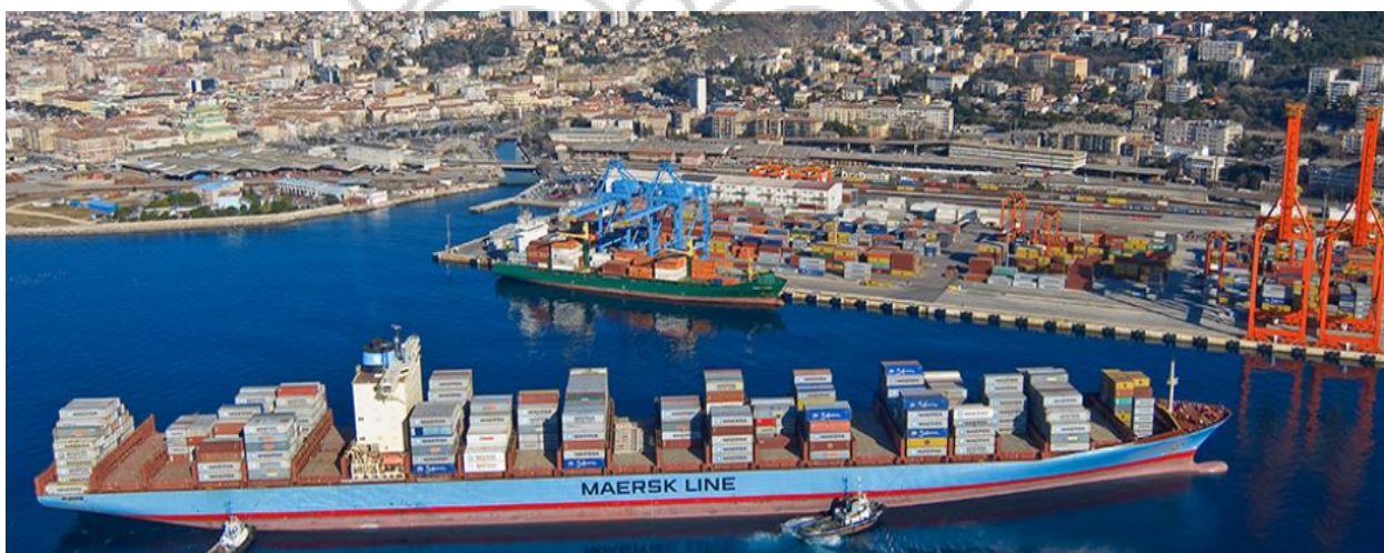
Slika 2. Kontejnerski terminal u Rijeci
