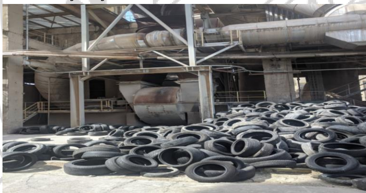
Slika 1. Gume ispred pristroja na ulazu u rotacionu peć
