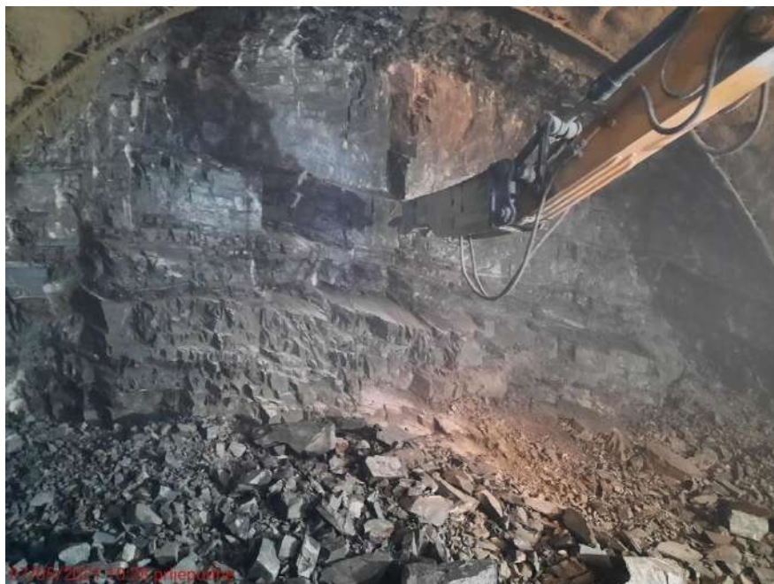
Slika 4: Radovi na iskopu tunela (foto E. Halilbegović)
