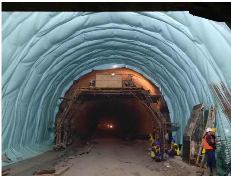
Slika 2: Hidroizolacija i oplata za sekundarnu oblogu tunela Zenica (foto E. Halilbegović)
