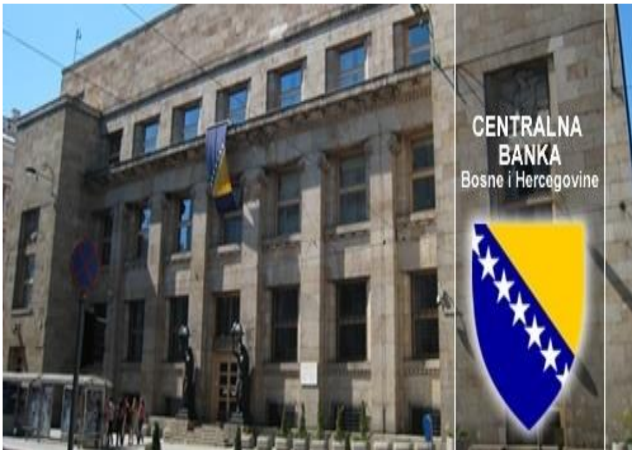
Slika 1. Zgrada Centralne banke Bosne i Hercegovine
