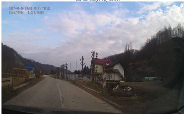
Slika 5. Nedostatak zaštitne ograde na mostu
