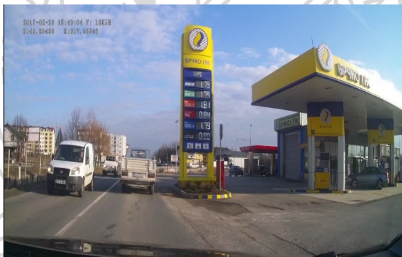
Slika 6. Nezaštićena željezna konstrukcija benzinske stanice
