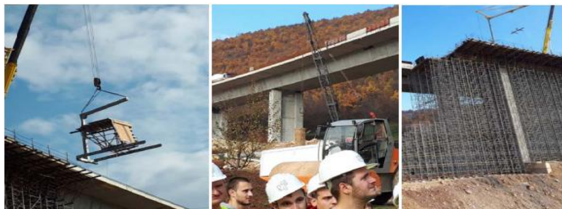
Slika 4. Izvođenje radova na vijaduktu Perin Han
