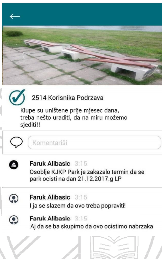
Slika 4. Komentari od građana i komunalnog preduzeća na novonastalu situaciju
