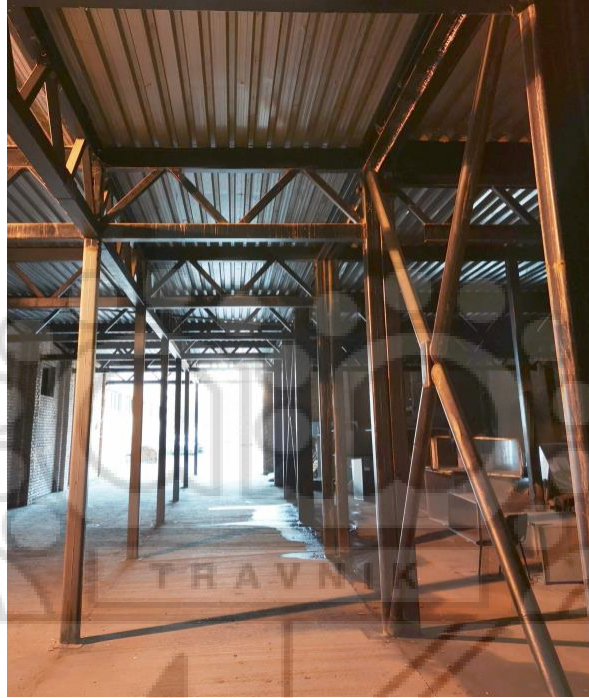
Slika 20. Postojeći spreg prizemlja u podužnom pravcu
