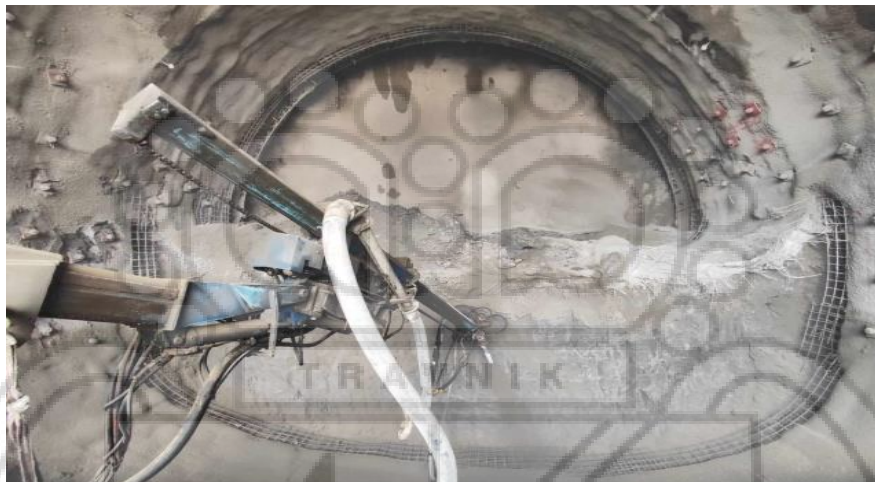
Slika 2. „Noseći prsten“ oko tunelskog iskopa ( kalota + stepenica + stalni invert + IBO sidra ) (foto. N. Halilbegović, 2023.)
