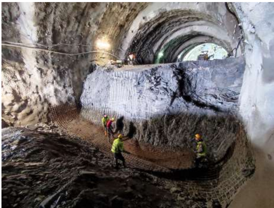
Slika 4: Radovi u tunelu: kalota, stepenica te armiranje inverta (foto N. Halilbegović, 2023)
