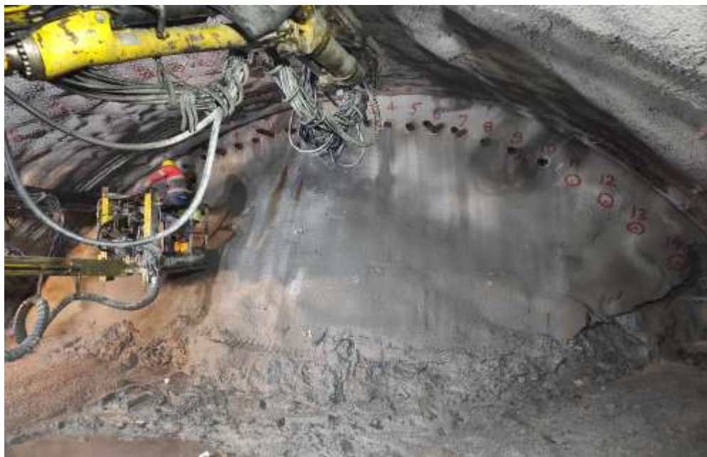
Slika 5: Ugradnja cijevnog štita - piperoof-a (foto N. Halilbegović, 2024)
